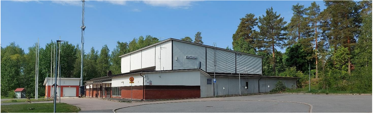
Suunnittelualueen länsipuolella palloilukentän vieressä sijaitsee 1984 valmistunut Kuntotalo, jossa on erilaisia liikuntatiloja (5/2024)
